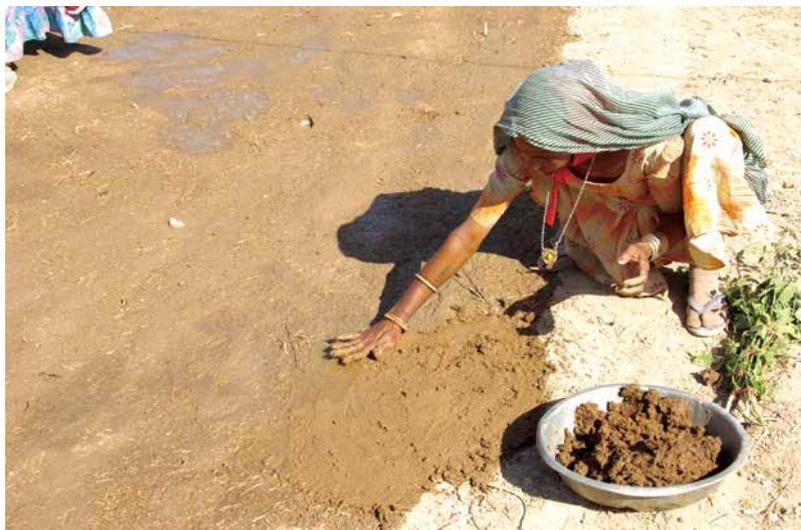
写真◎牛糞を用いた土間作り 1
