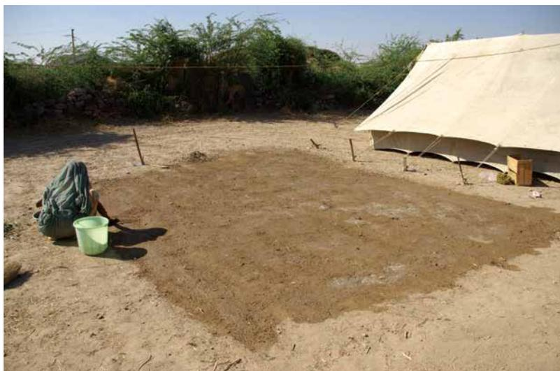
写真◎牛糞を用いた土間作り 2
