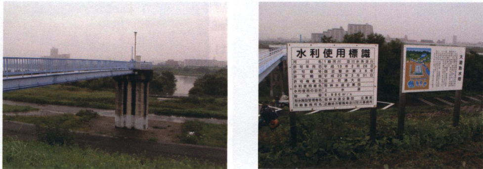
写真 2.1-2 「取水施設」及び「水利使用標識」(2004/9/2)
