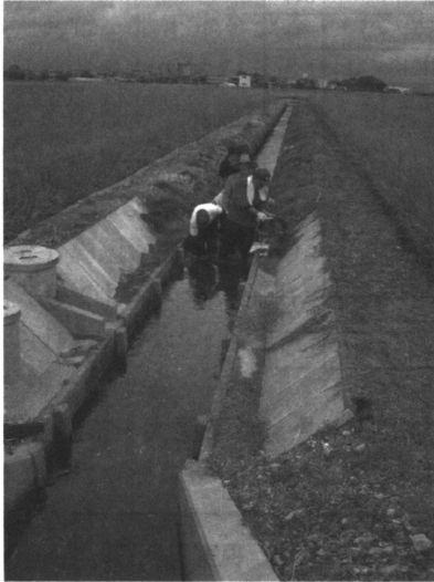
図10 Dの川筋の作業の様子
