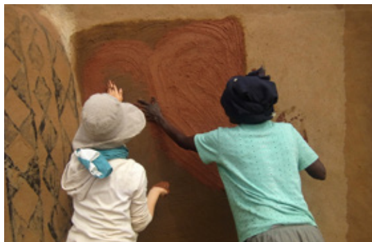
写真④気温が高く塗りつけた層がすぐ乾くので次の塗りに入る 写真⑤手になじむ小石を選ぶ 写真⑥小石でつるつるに磨く
