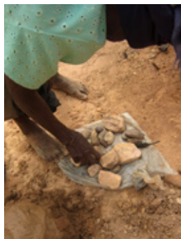
写真④気温が高く塗りつけた層がすぐ乾くので次の塗りに入る 写真⑤手になじむ小石を選ぶ 写真⑥小石でつるつるに磨く
