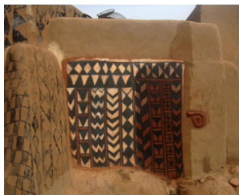
写真⑩白い石(カオリン)でこすり磨く 写真⑪左が前日に作った壁画、右は白を描いている途中 写真⑫ネのエキスを帚でかける
