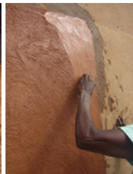
写真④気温が高く塗りつけた層がすぐ乾くので次の塗りに入る 写真⑤手になじむ小石を選ぶ 写真⑥小石でつるつるに磨く
