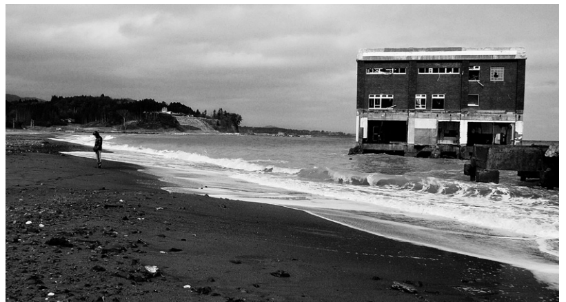
小泉海岸の被災地。海の中のビルはかつてホテルとしてつかわれた建物で、周囲には松林が広がっていた。現在ビルは撤去され、左手に巨大防潮堤が建設されている(2014年3月)
