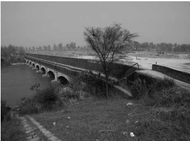
写真 14 ローバル付近で灌漑水路上を高架でまたぐ サトレジ川の支流
