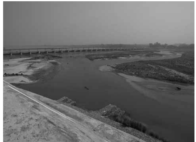
写真 15 ローバルのサトレジ川の取水堰
