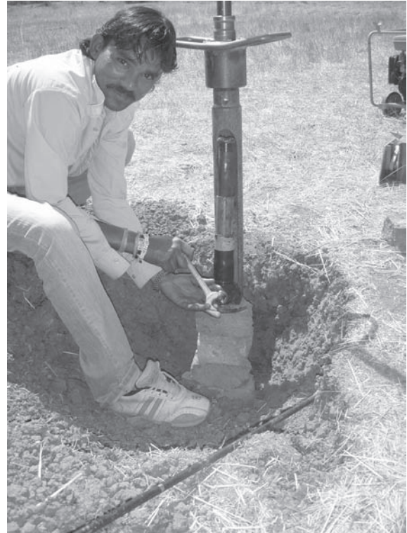
図 2 パーカッション式ドリラーによる掘削の様子
