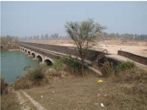
写真 13 ロパール付近で灌漑水路上を高架でまたぐ サトレジ川の支流
