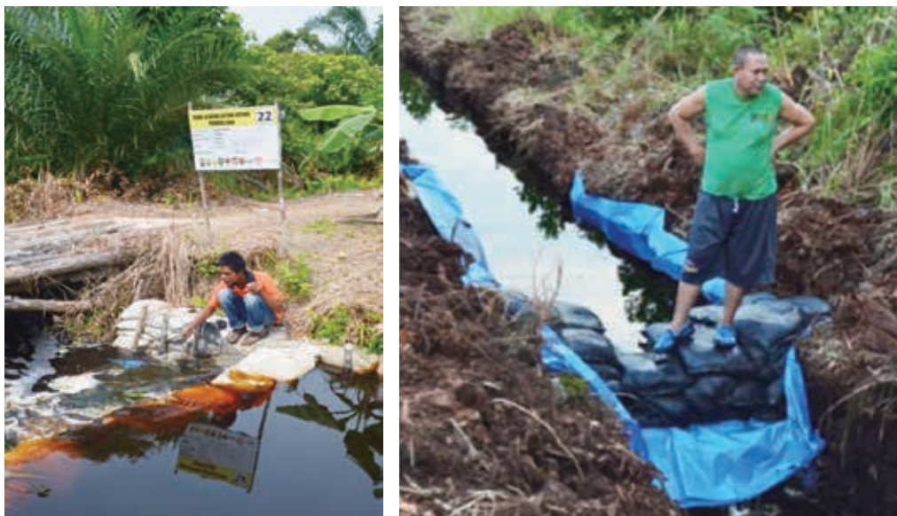
図3 タンジュンバン村における小規模貯水池の設置 2014年10月：住民イニシアティブによるコーザン・メソッド泥炭地湿地化の例（甲山による）
