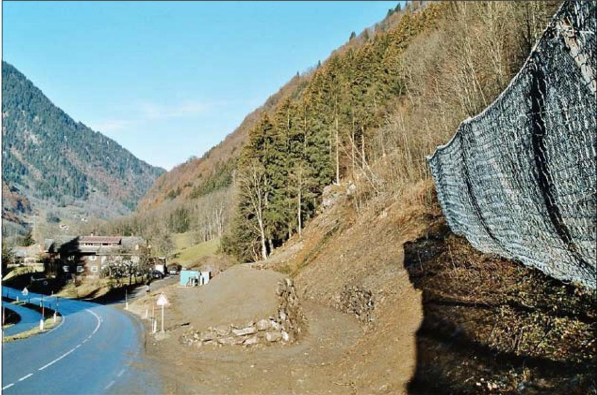
図3. 落石の危険性があるオーストリアの山道に、アルプスで一般的に使用されている3つの異なる保護対策（落石防止ネット、落石防止ダム、保護林）を施したもの（Credit: L. Dorren, 2004）
