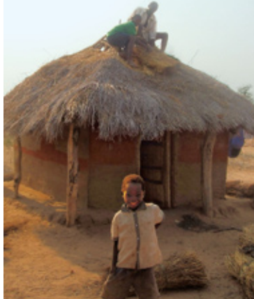
調査期間中に私が使う家屋の屋根を、同居している家族が直してくれているところ
