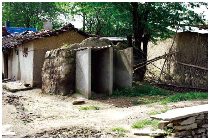
写真②村に新規設置されたトイレ(ラージャスターン州)
