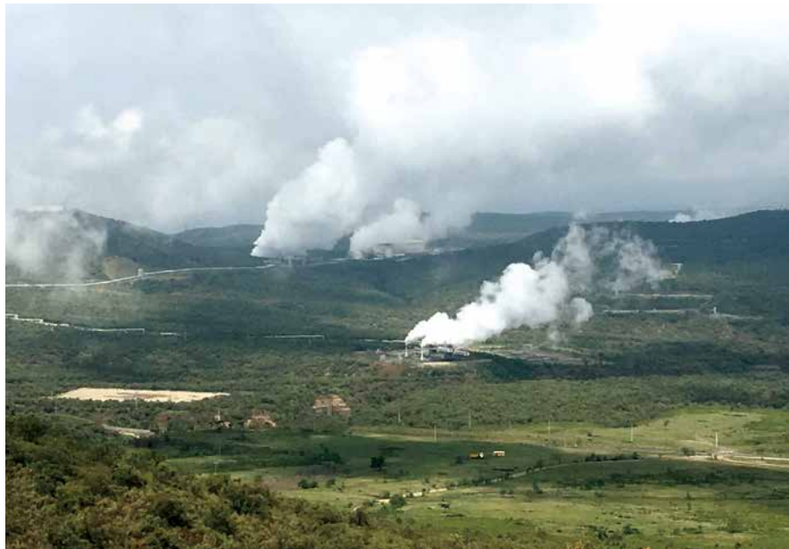
写真①リフトバレーにつくられた地熱発電所
