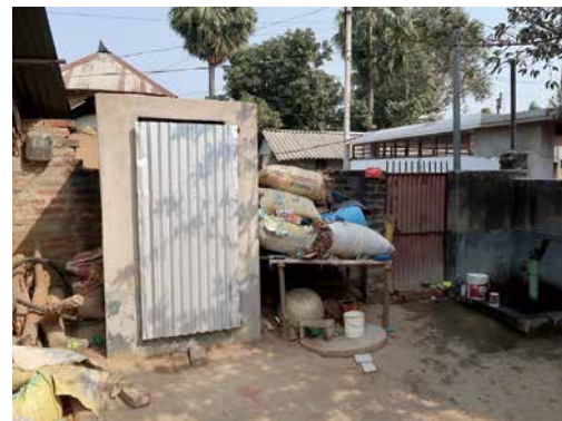
写真④無償で設置されたトイレ
