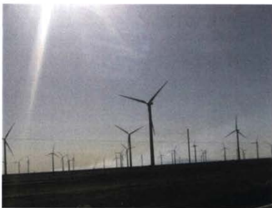
写真4 嘉峪関と安西の間あたり。砂漠に風車が立ち並ぶ。
