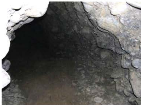
写真8. 暗渠本道、高さ約1.5m (鷲落峽)
