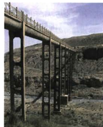
写真 16. 擺浪河に架かる水道橋
