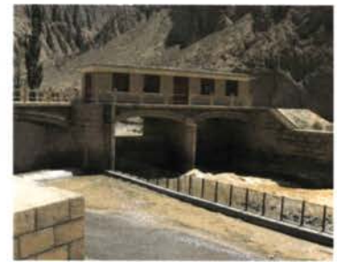
写真 15. 閘房の取水堰（西洞子壩）
