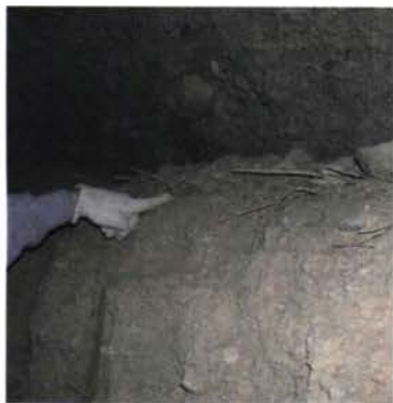
写真7. ワラを敷き込んだ版築層 (西洞子壩)
